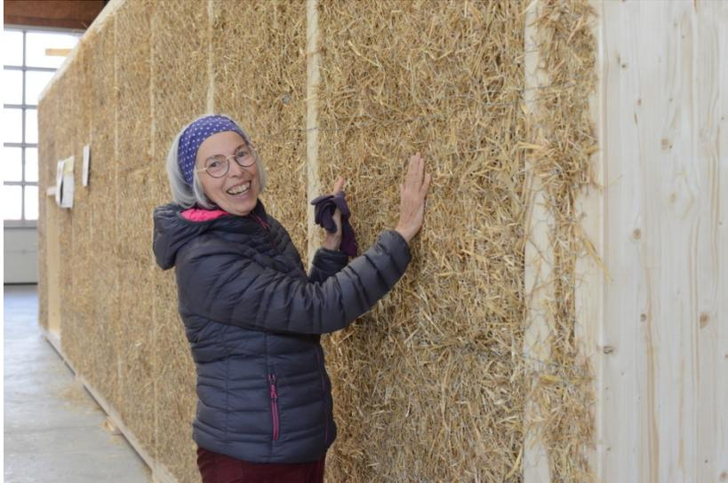
Das Wiegestubenhaus wird zuerst gebaut. Die Elemente dazu samt allen Fenster- und Türöffnungen sind bald transportbereit, sie werden draussen aufgerichtet, sobald die Beton-Bodenplatten auf dem Bauplatz fertig sind.
